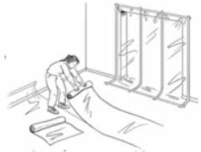
Figura 2. Colocación del forro protector.
